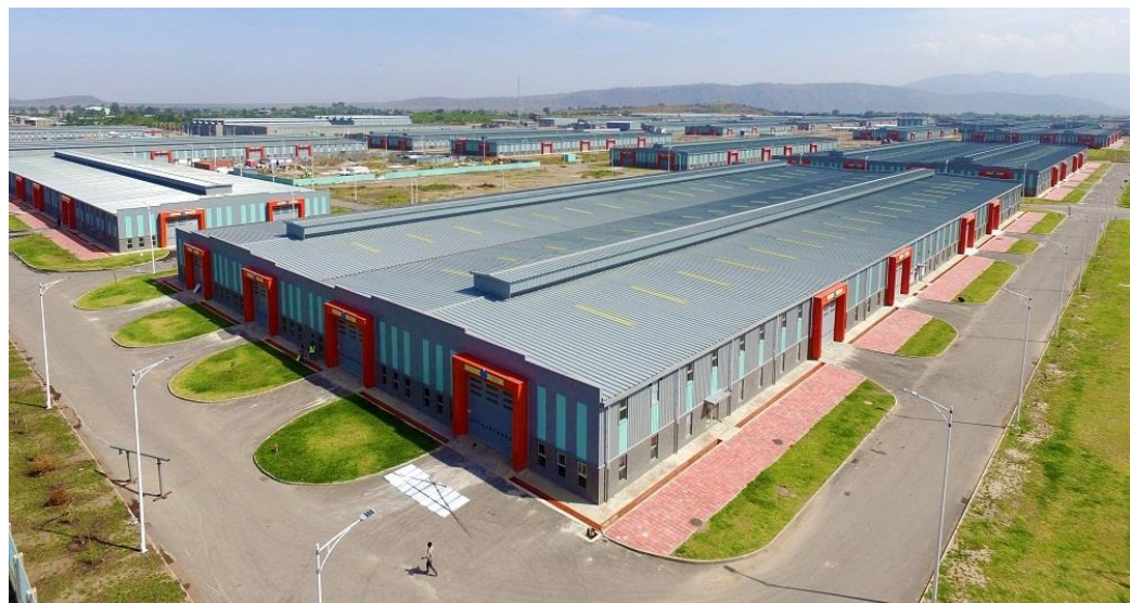
Fig. 9.3.1. Hawassa Industrial Park
